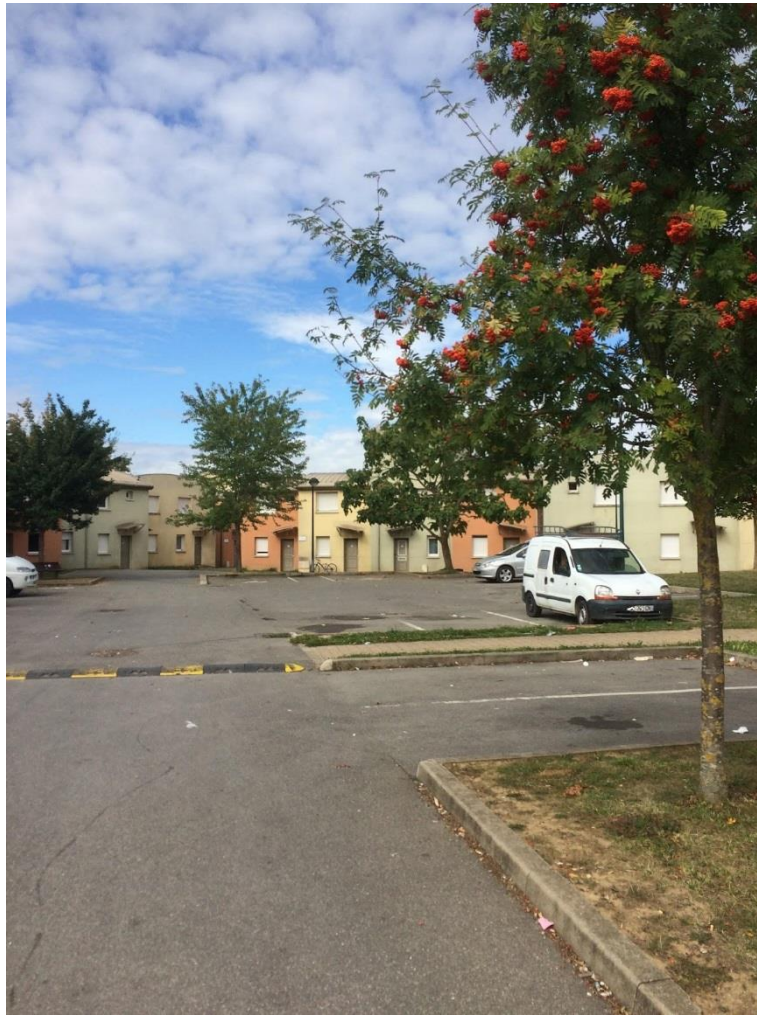
Entrée de l'Appart'Hôtel de Montévrain. Source : photo Odile Macchi, août 2017.
